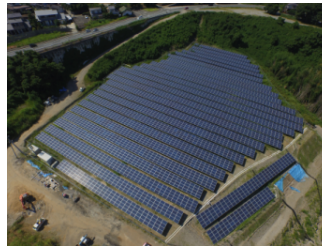
熊本県山室 1.2MW
